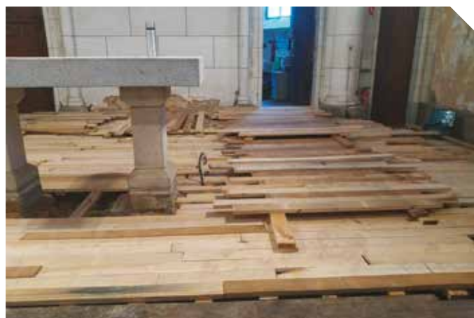
Le parquet en attente de pose
