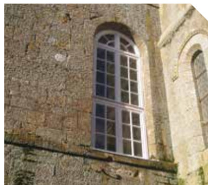
La fenêtre fraîchement posée
